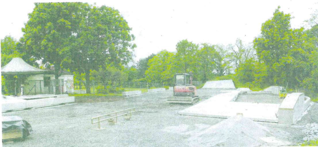
Immer mehr Elemente werden im Skatepark installiert: Sie werden als Betonfertigteile in Bayern gegossen und nach Hockenheim gebracht.
